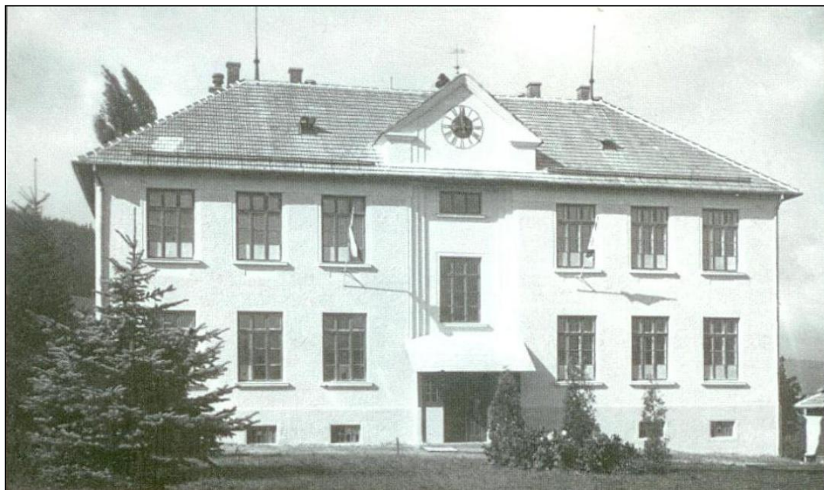
Budova učeben SVRRG (původní základní škola barákového utečeneckého tábora), dnešní budova č. 33, v níž se učí management
